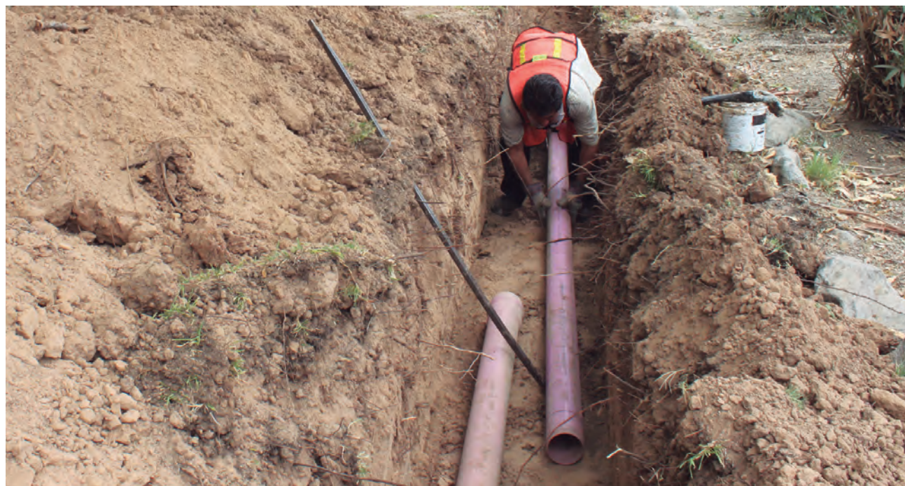
Instalación de tubería morada en Mexicali, B.C.
