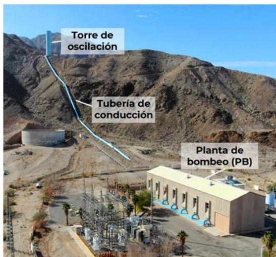
Figura 13. Principales componentes de una de las seis plantas de bombeo del Acueducto Río Colorado – Tijuana (ARCT)
