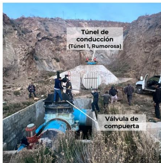
Figura 14. Entrada de túnel ubicado en La Rumorosa, Tecate
