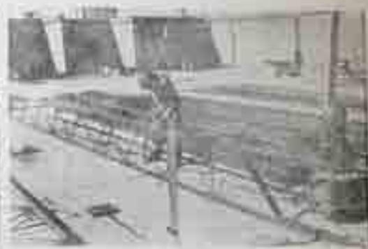
Trabajadores en el Mercado Municipal en Tijuana, Baja California, en el mes de enero de 1961. Se ven los muros de concreto y las vigas de acero que forman la estructura del edificio.
