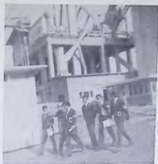
Aspecto de nuestra visita a la Termeléctrica de Rosarito, B. C.
