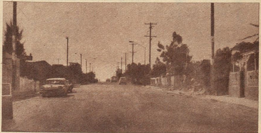
La comunicación por vías pavimentadas de las colonias con el sector central de las ciudades del Estado, ha tenido gran desarrollo durante los últimos tres años. Aquí se ve una de las calles antes terregosas de Mexicali, recientemente pavimentada.
