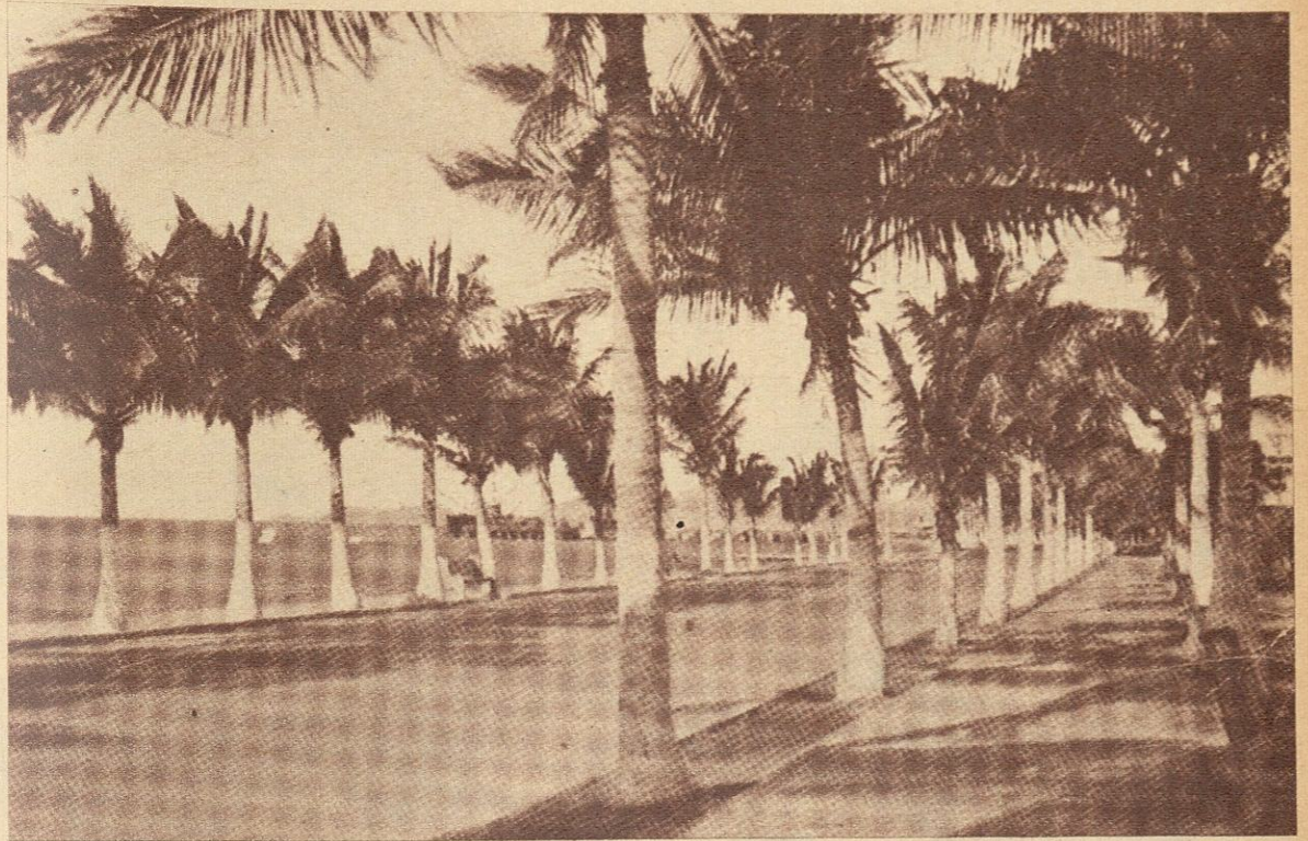
Calzada de las palmeras por la orilla del mar.
