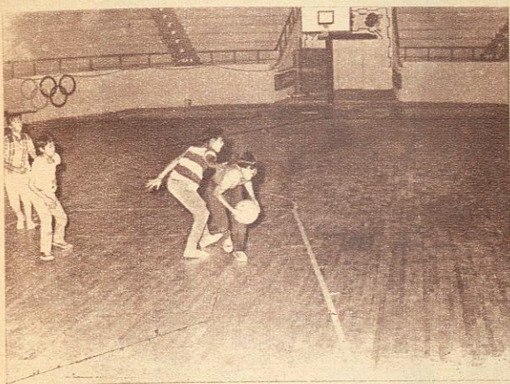
ASPECTO INTERIOR DEL Auditorio Municipal en el que puede verse la cancha de basquetbol. Esta obra fue realizada por el Patronato Pro-Construcción de la Casa de la Juventud.
