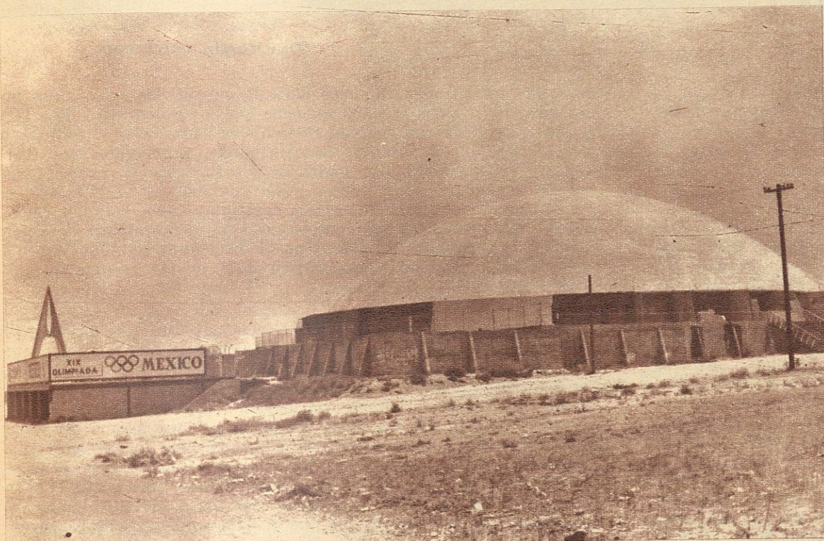
EN LA GRAFICA puede apreciarse la enorme cúpula de estructura de fierro recubierta totalmente de gasoconcreto, obra que fue realizada por indicaciones del Patronato Pro-Construcción de la Casa de la Juventud y en la que se han invertido a la fecha $2,698,004.64. La obra fue realizada en cinco meses y entregada a la juventud deportista el 15 de septiembre de 1967. Esta obra fue planeada por el extinto Gobernador Ing. Eligio Esquivel Méndez y durante años estuvo paralizada hasta que el actual Gobierno del Estado la cedió para su terminación y usufructo al actual Patronato Pro-Construcción de la Casa de la Juventud.
