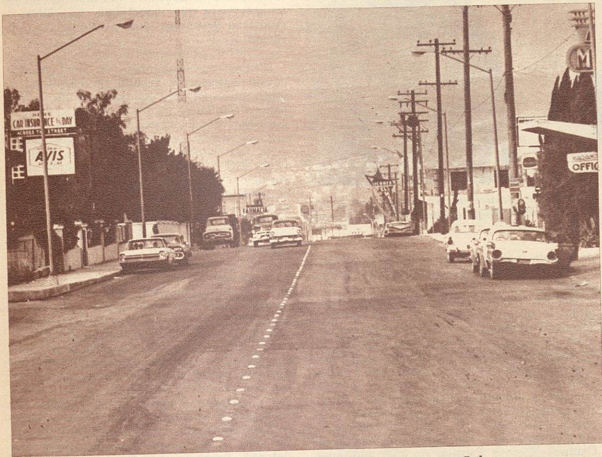
Reencarpetao de calles y moderno sistema de señales
