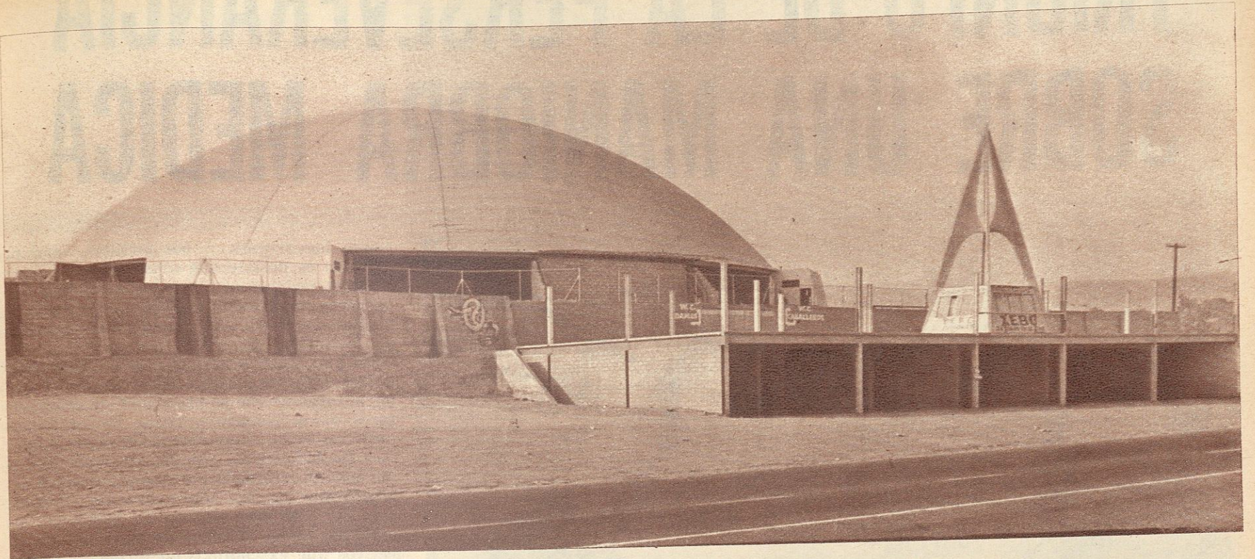
El auditorio de Tijuana quedó terminado mediante fuerte inversión
