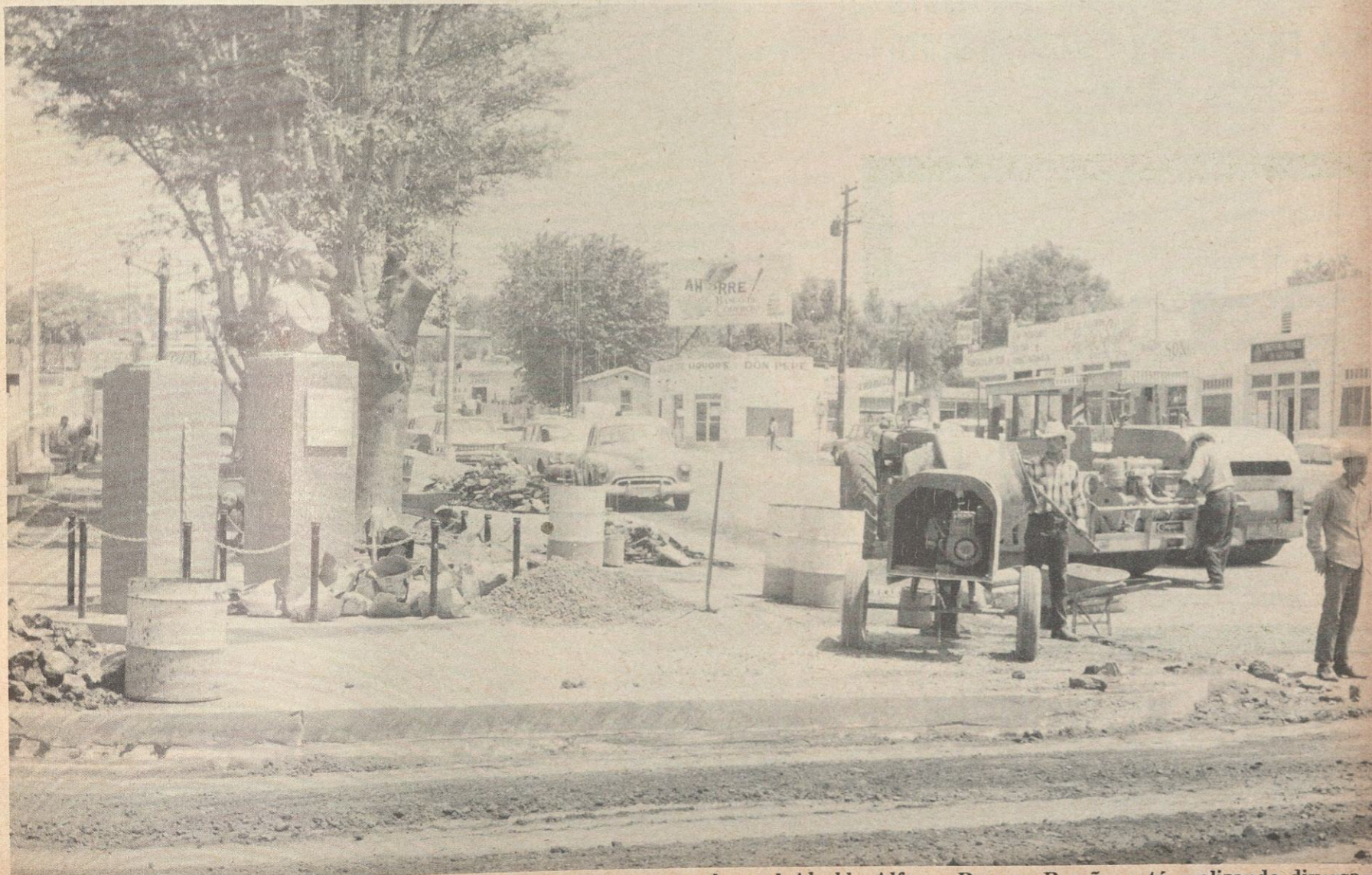
Con entusiasmo y determinación, la administración pública que encabeza el Alcalde Alfonso Romero Bareño, está realizando diversas obras de restauración de la plaza principal de la población, el Parque Hidalgo. Las obras incluyen la instalación de alumbrado mercantil, encementado de los andadores y embellecimiento de los prados.
