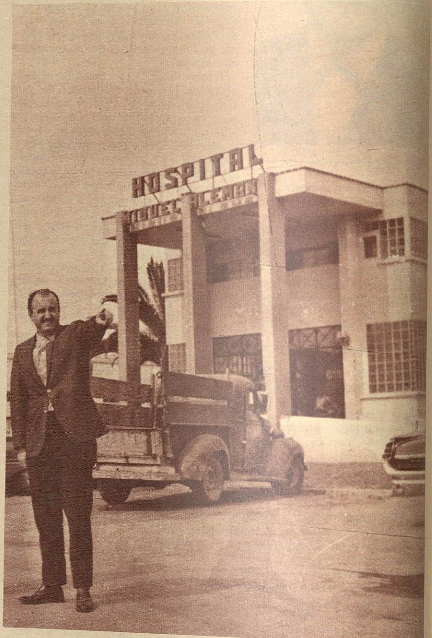
Fachada del Hospital
