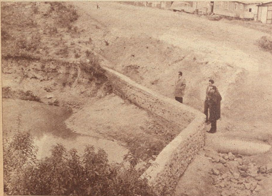
Poco a poco se fueron abriendo calles y con el auxilio de las autoridades se construyen obras para el control de las aguas provenientes de las lluvias.
