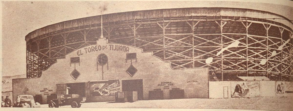
Al quedar terminado el Toreo de Tijuana, en 1938, así lucía para orgullo de los tijuaneses que se ufanan de contar con ese magnífico coso. Posteriormente fué ampliado hasta quedar como ahora se encuentra.
