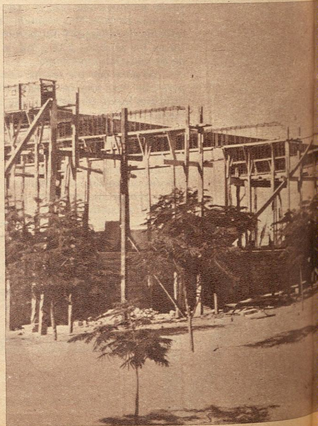
Vista de las obras de la ETIC
