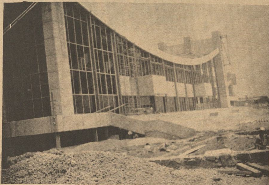
EL Palacio de los Deportes: Obra monumental de reciedumbre básica
