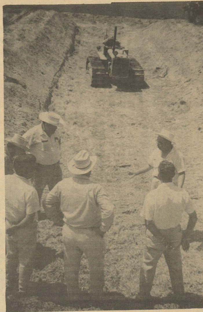
Los silos trinchera son construcciones rústicas que se hacen aprovechando un barranco natural del terreno o construcción hecha especialmente para depositar en ellos el ensilado de pasturas, como el que aquí se construye.
