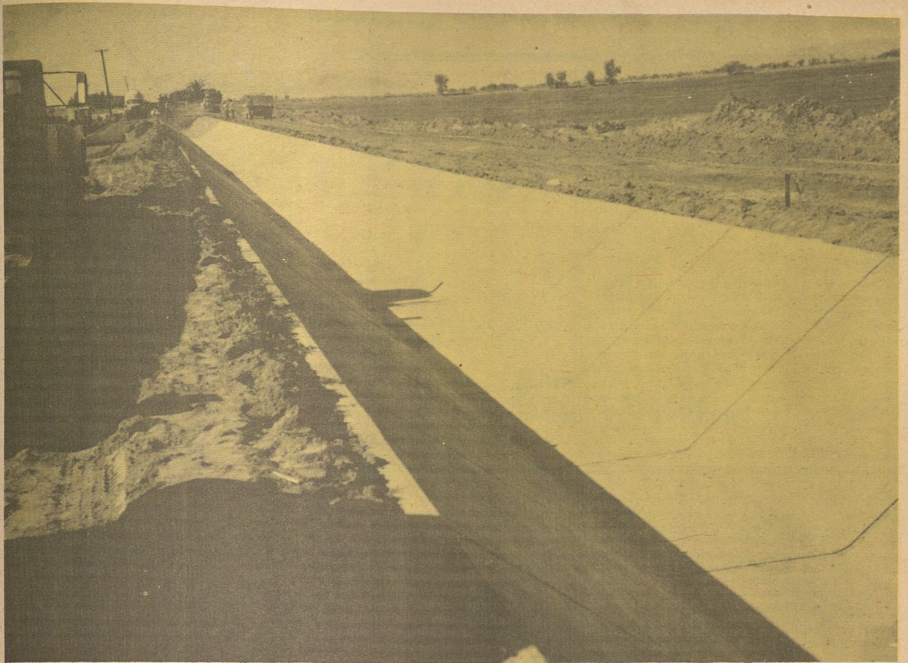
CANALES revestidos como el que aparece en esta gráfica serán tendidos en todo el Valle de Mexicali una vez que se rehabilite el Distrito de Riego.
