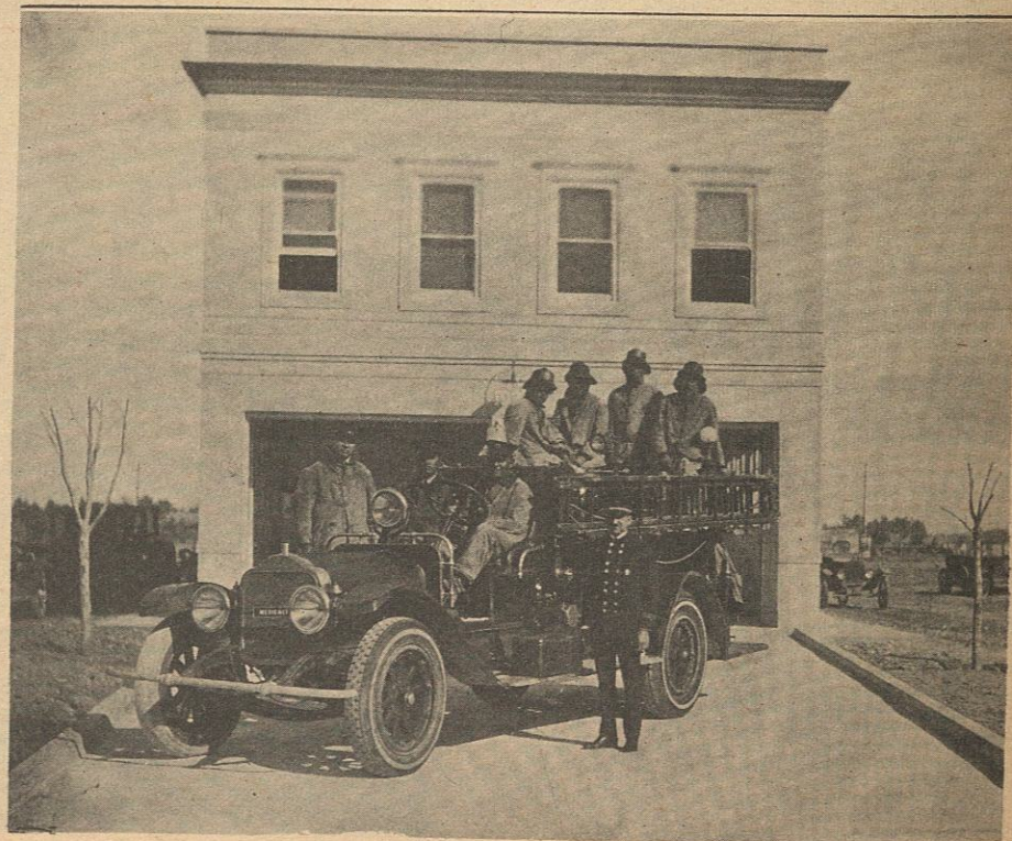
Edificio del Cuerpo de Bomberos de Mexicali, B. Cfa. Su costo fué de $20,000.00.
