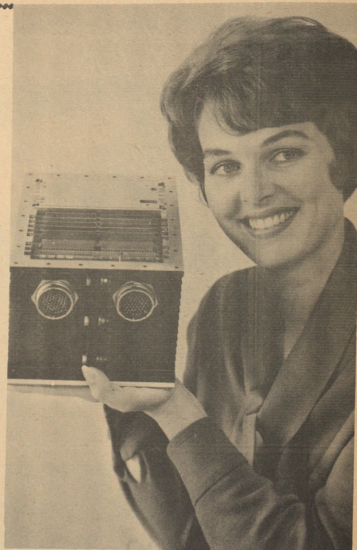
CIRCUITO EN MINIATURA. —Este circuito instalado en una delgada película es uno de los 80 en miniatura que componen la computadora digital de 11.7 kilogramos perfeccionada para la aviación de los Estados Unidos por la International Business Machines Corporation. Cada una de estas planchas de 6.35 por 4.76 centímetros lleva instalados 32 circuitos y los hilos correspondientes que los conectan.
