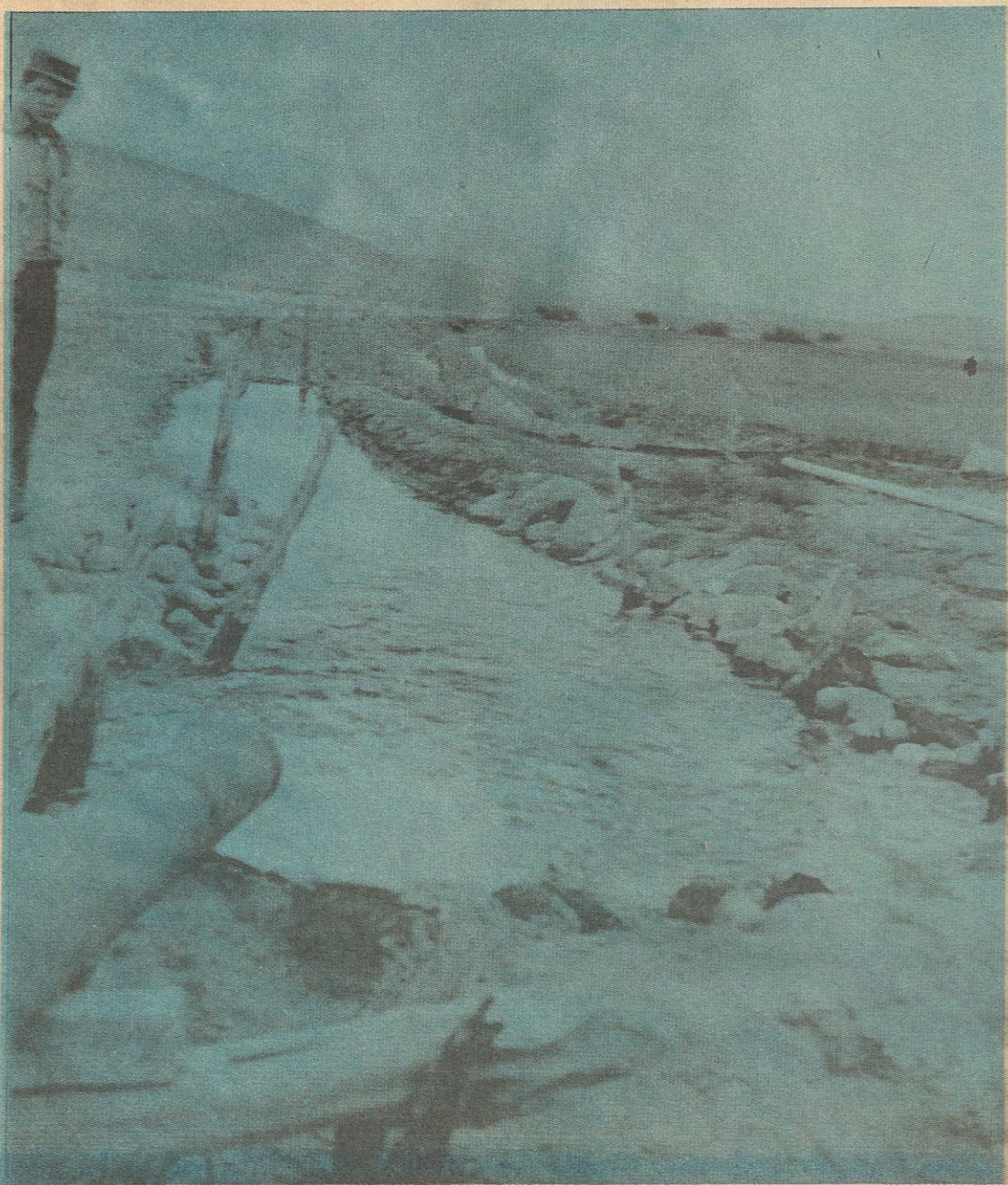
Es indispensable revestir los canales para evitar que el agua se pierda inútilmente.
